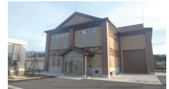
宮竹用水第二発電所 手取川宮竹用水土地改良区 ●最大使用水量 6.50m 3 /s ●有効落差 11.65m ●最大出力 580kW
