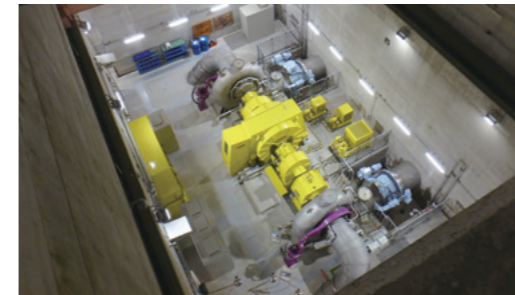
八ッ場発電所 群馬県企業局 ●最大使用水量 13.60m 3 /s ●有効落差 105.8m ●最大出力 11,700kW
