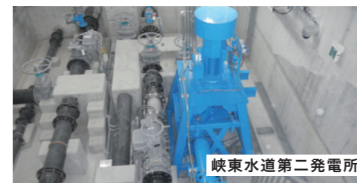
峡東水道 山梨県企業局 【第一発電所】 ●最大使用水量 0.201m 3 /s ●有効落差 79.00m ●最大出力 100kW 【第二発電所】 ●最大使用水量 0.087m 3 /s ●有効落差 70.20m ●最大出力 35kW
