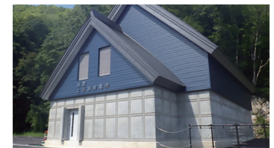
上百瀬発電所 富山県企業局 ●最大使用水量 1.0m 3 /s ●有効落差 81.50m ●最大出力 670kW
