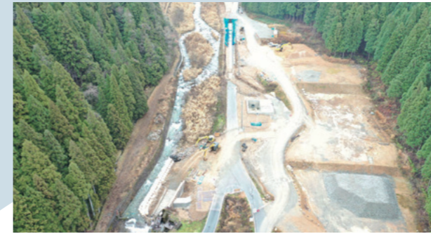
別又谷発電所 2024年6月運転開始予定 ●最大使用水量 2.6m 3 /s ●有効落差 20m ●最大出力 440kW
