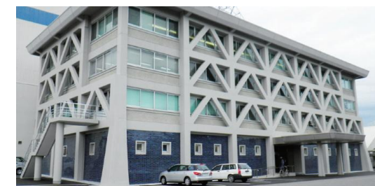
耐震診断、耐震補強及び監理業務
