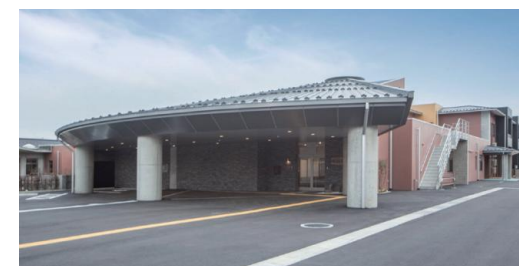
特別養護老人ホーム大江苑 増築工事
